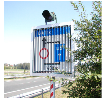
Die Lamellen von Wechselverkehrszeichen erlauben nicht nur eine Anpassung an die Verkehrslage, sondern bieten auch eine Funktion zum Abschütteln von Schnee.
